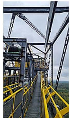
Bild 2: Auf der Brücke
